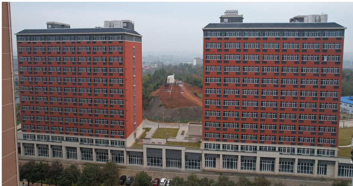
图 6-1 学校新建的宿舍楼
